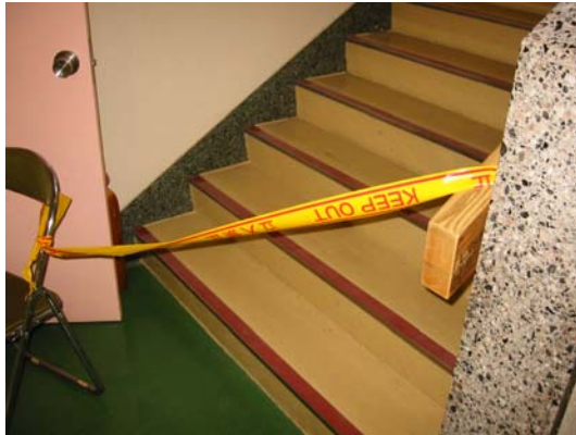
危険な箇所はテープ等で立ち入り禁止とします
