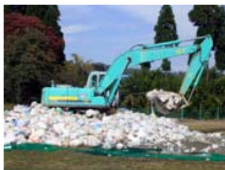
臨時ごみ積置場のイメージ (写真：阪神・淡路大震災時に学校の校庭に設置された臨時ごみ積置場)
